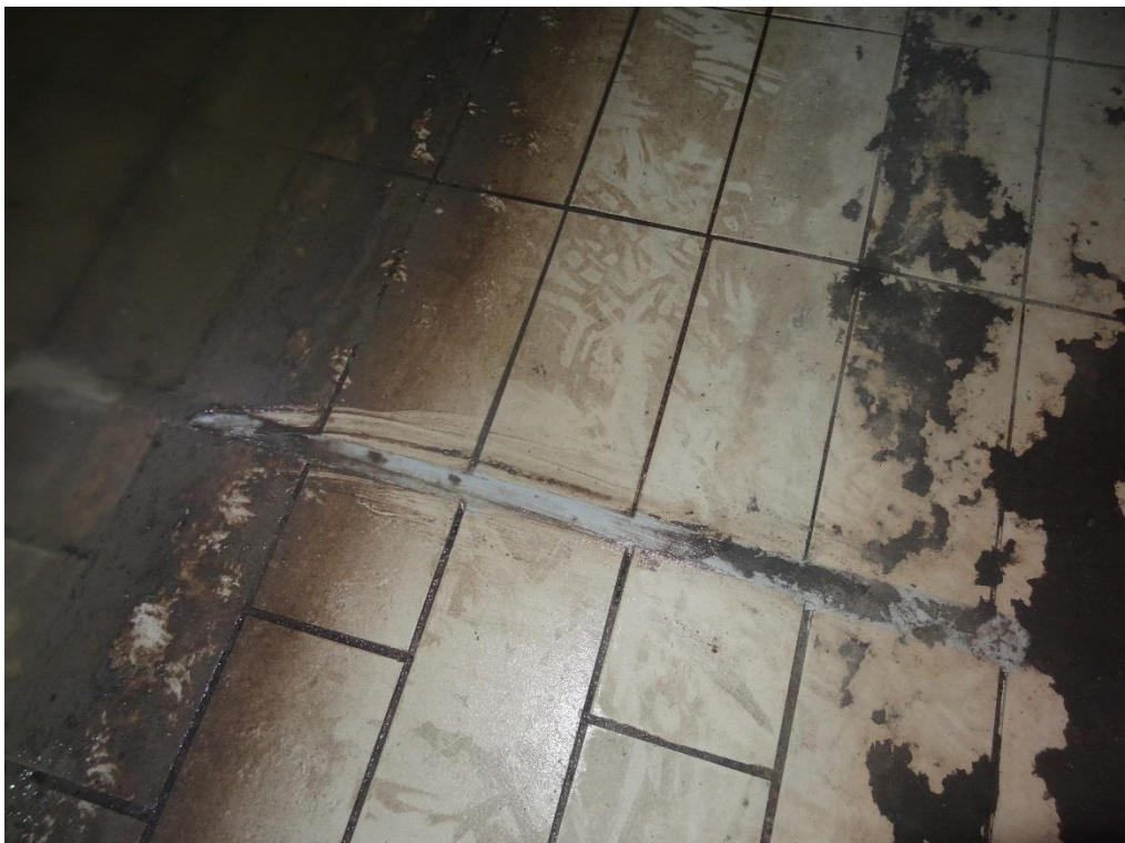
Abbildung 4 Sanierte Fuge zwischen KS 67 und KS 59
