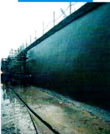
Ansicht der fertigen Instandsetzungsarbeiten im Kanal Bertini - Robbiate (Como) - Italien
