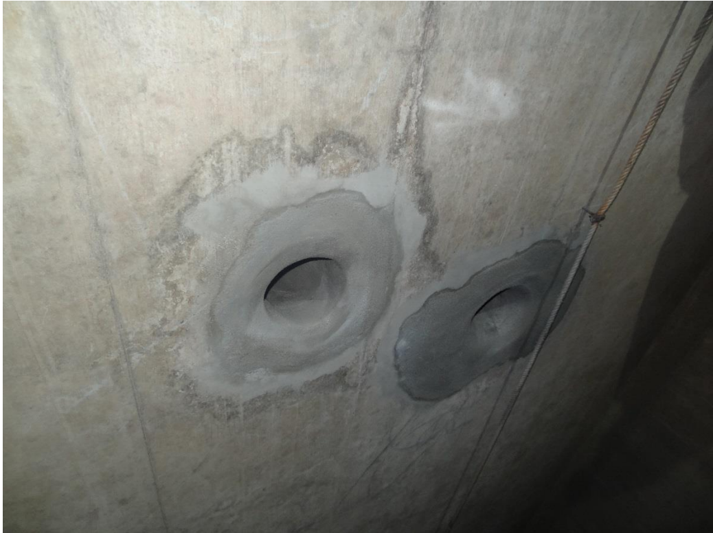
Abbildung 1 Sanierte seitliche Anschlüsse zwischen KS 72 und RA V
