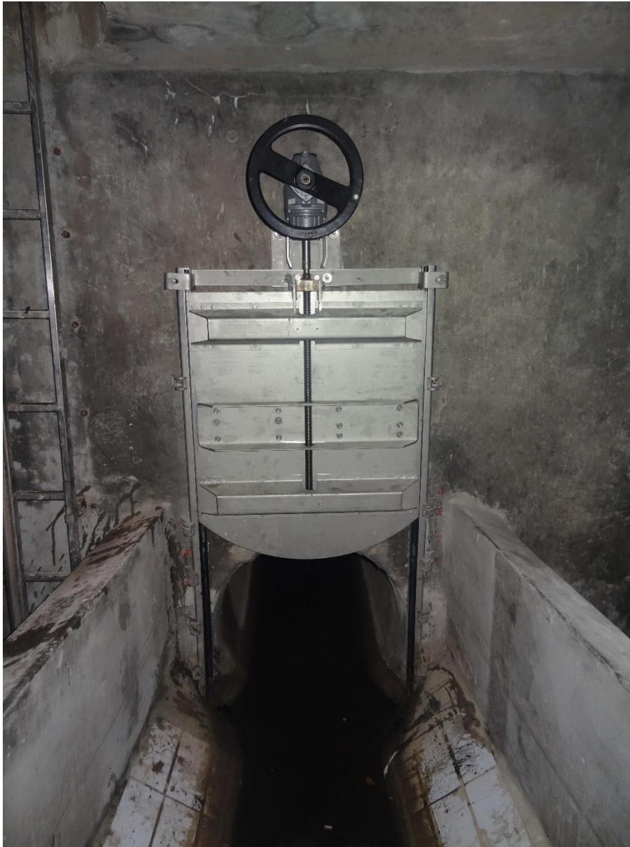
Abbildung 5 neu montierter Wey Normschütz zur Regulierung der Weiterleitungsmenge
