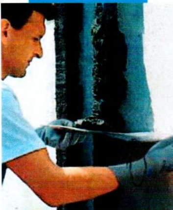
Abziehen von Mapegrout-Mörtels mit einer Schablone
