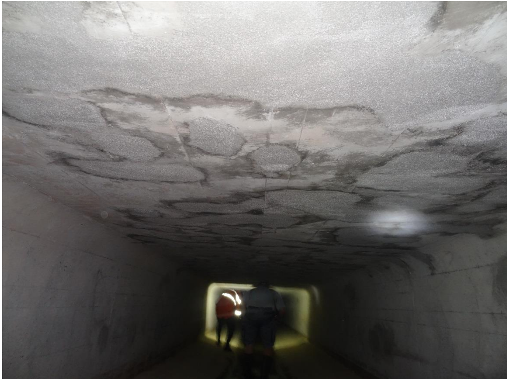
Abbildung 3 Reprofilerte Betonschäden im Deckenbereich zwischen KS 59 und RA IV
