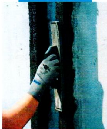
Nachbehandlung des Mapegrout-Mörtels
