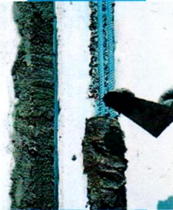
Aufbringen von Mapegrout Tissotropico
