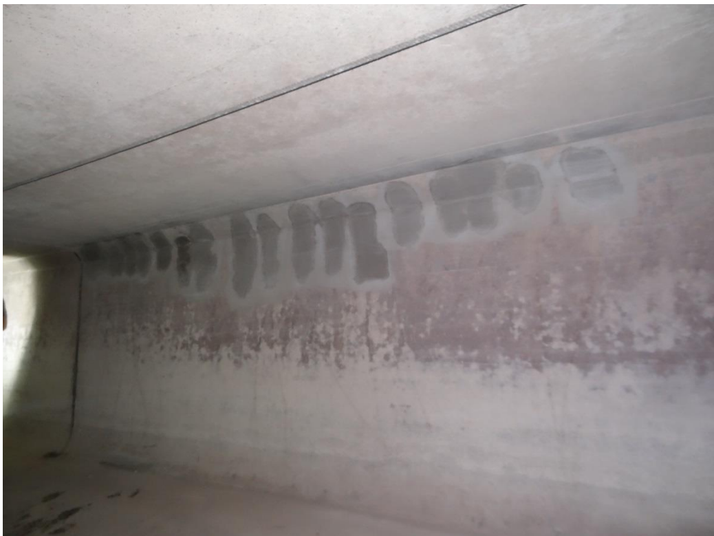
Abbildung 2 Sanierte Betonschäden, Eisen zurückgeschlagen um genügende Bewehrungsüberdeckung von ca. 20mm zu erreichen. KS 72 - RA V
