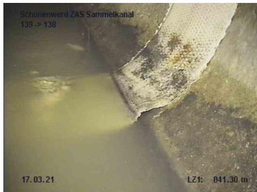
Abbildung 4 KS139 - KS138 Partliner löst sich
