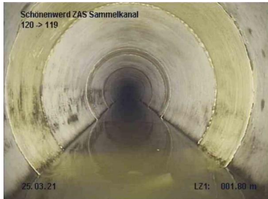
Abbildung 2 KS120 - KS119 Partliner löst sich
